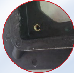
الإطار مزود بزوايتين مع أسنان لتثبيت الغطاء Frame has 2 corners with threads to lock cover.
