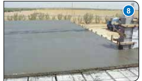
صب طبقة خرسانة بسبك لا يزيد عن 7 سم (اختياري)
