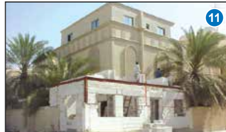
المبنى أثناء تركيب البلاطات
