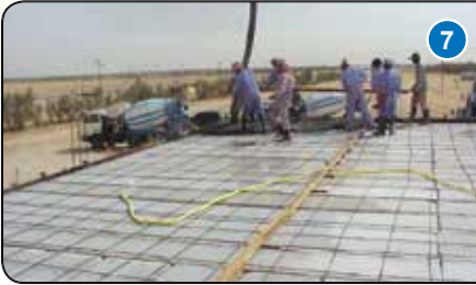
وضع شبكة حديد تسليح قطر 8 مم (اختياري)
