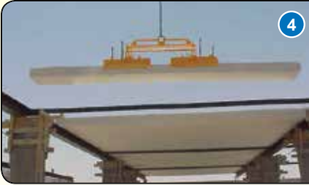
تركيب البلاطات بشكل متجاور
