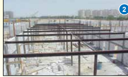
هيكل حديدي قبل التركيب للمباني الواسعة
