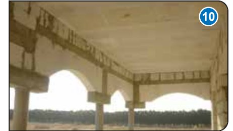
شكل البلاطات بعد الانتهاء من التركيب
