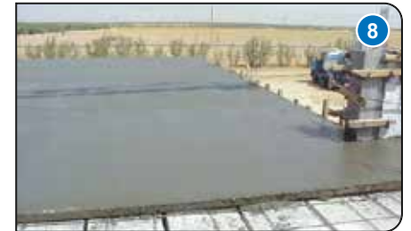
صب طبقة خرسانة بسمك لا يزيد عن 7 سم (اختياري)
