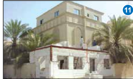
المبنى أثناء تركيب البلاطات
