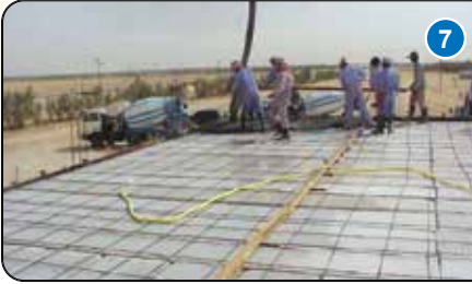
وضع شبكة حديد تسليح قطر 8 مم (اختياري)
